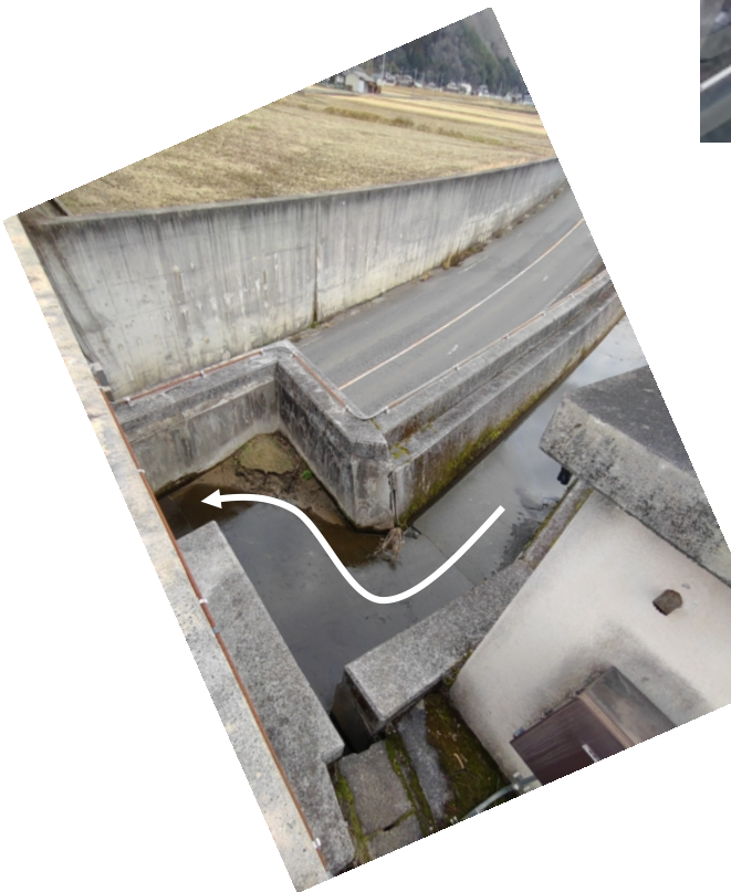
暗渠入口 暗渠内のほぼ全部の床コンクリート板が剥がれている。
