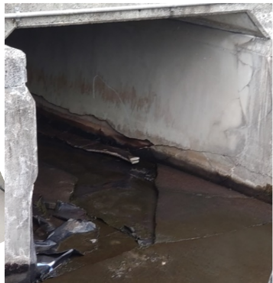
暗渠入口 暗渠内のほぼ全部の床コンクリート板が剥がれている。
